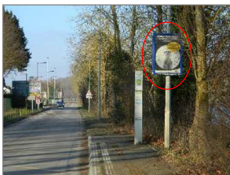
Exemple de panneau publicitaire illégal car fixé sur une installation d'éclairage public
